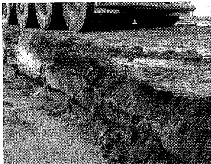
Deels afgegraven wegdeel, met onderaan zichtbaar laag zinkas.
