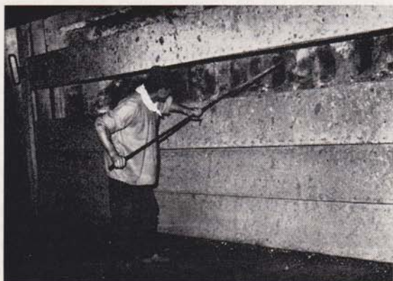
Het afdichten van het ovenfront
